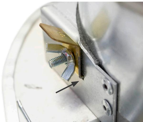
**FDMS retrofit limit switch installation**
